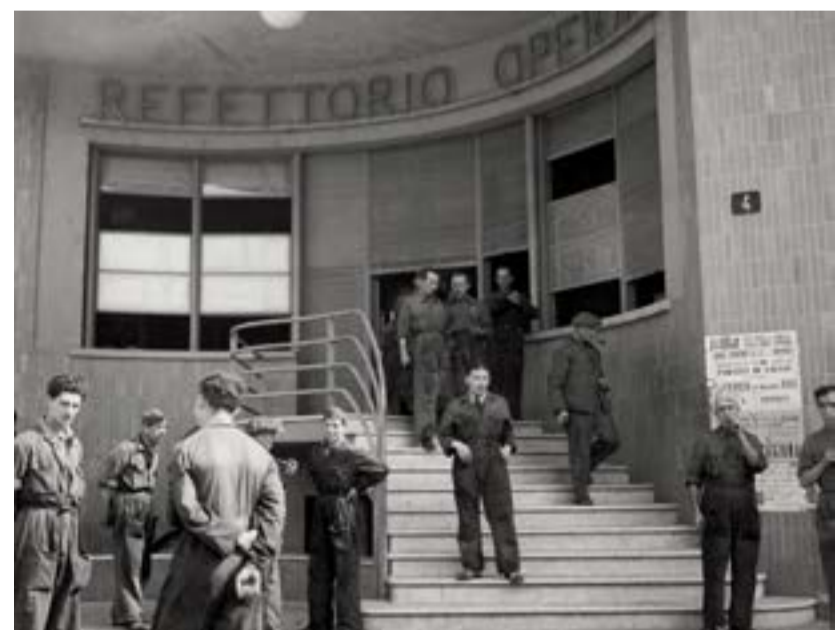
Umberto Da Re, Mensa aziendale Dalmine, 1940 , Fondazione Dalmine
